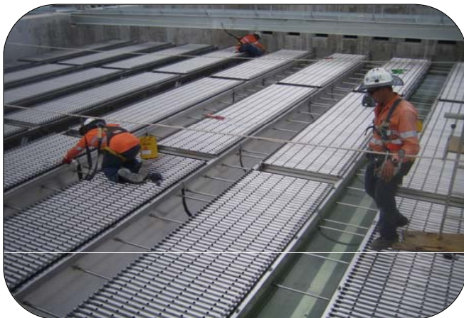
위어(Weir) 수평 조정 후 설치 완료
