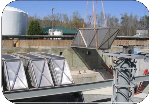
서포트 빔 설치 후 경사판 모듈 양중
